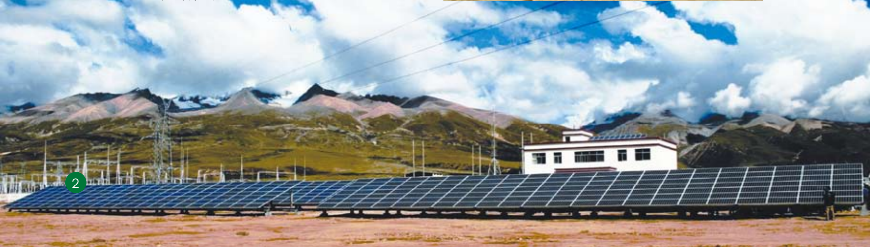
● 西藏羊八井高压并网光伏电站
