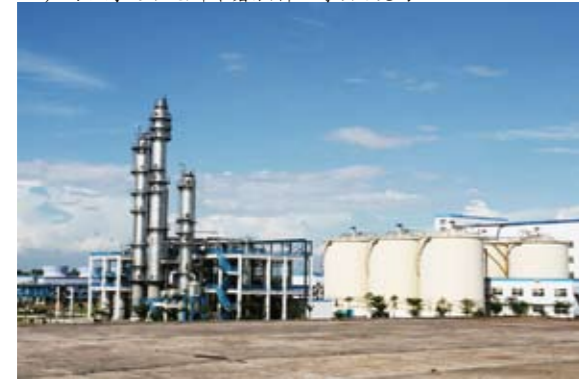
● 广西北海20万吨/年木薯燃料乙醇项目现场
